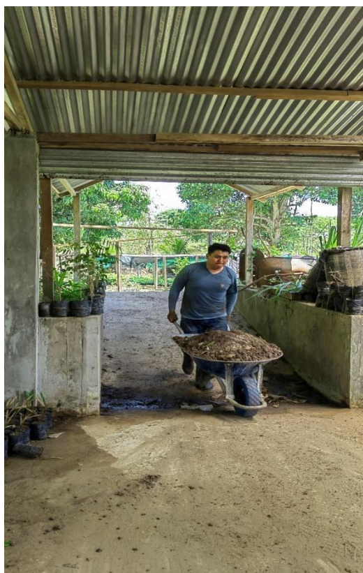
Figura 15. Acondicionamiento de tierra
