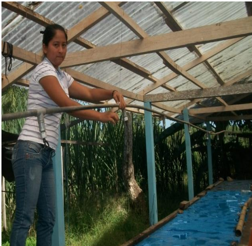
Anexo 02. Construcción del túnel de nebulización
