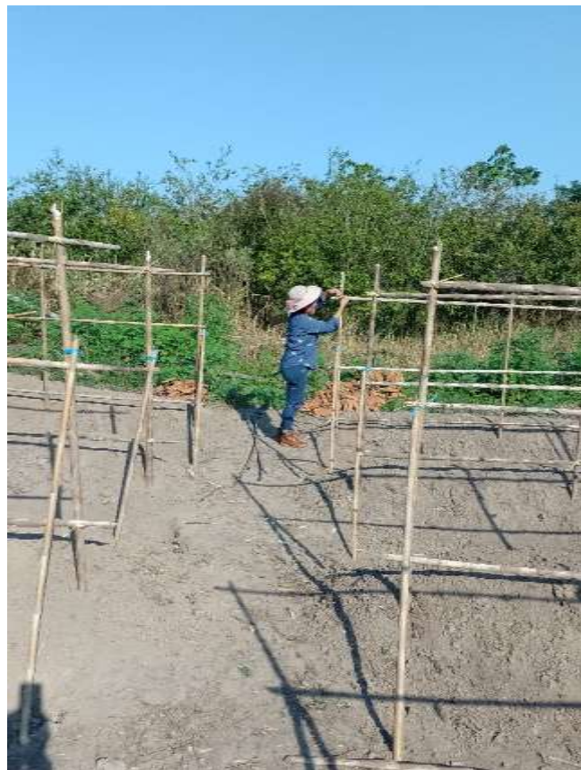
Figura 20. Amarrado de la caña brava para las espalderas
