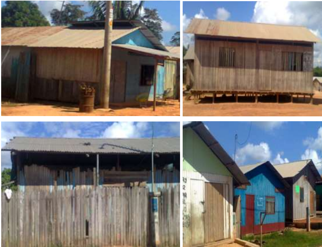
Figura 03. Casas con techo calamina de la Comunidad Intercultural Benajema.
