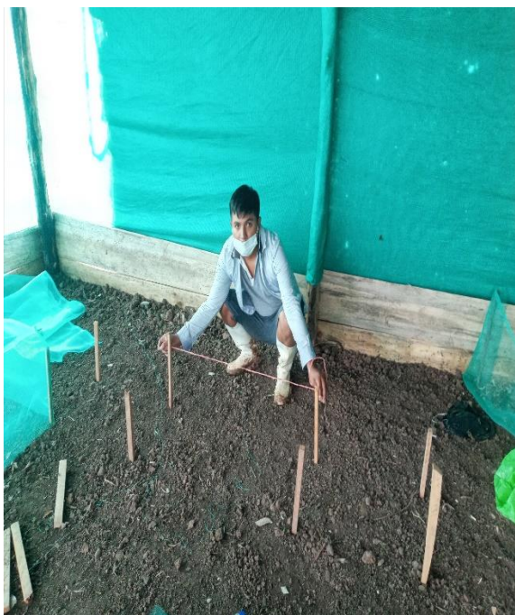
Figura 15. Construcción de corrales interiores.
