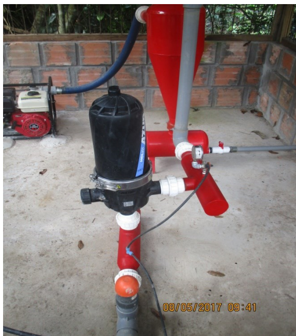
Figura 5. Instalación del cabezal de riego. Fuente: Elaboración propia, 2017.
