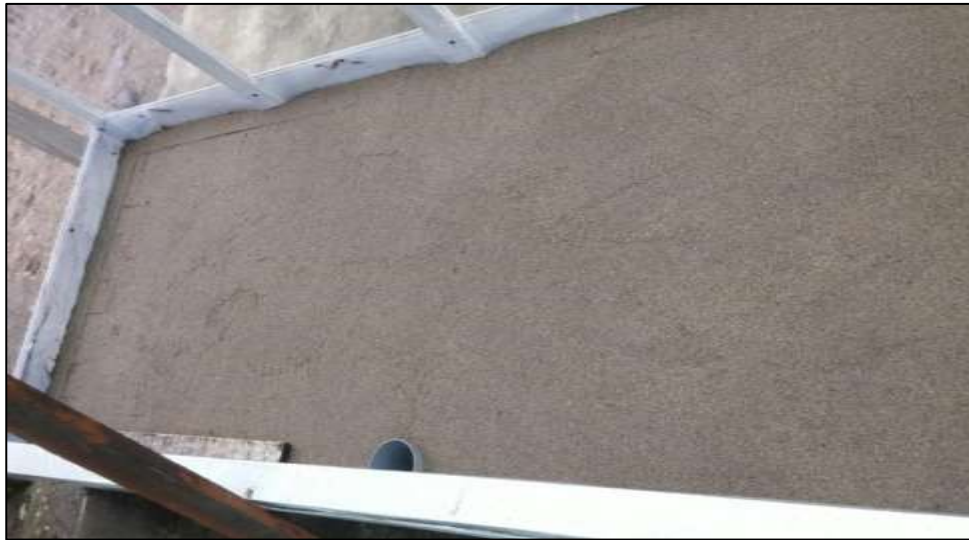
Figura 17. Nivelación de arena fina en la cámara de subirrigación.
