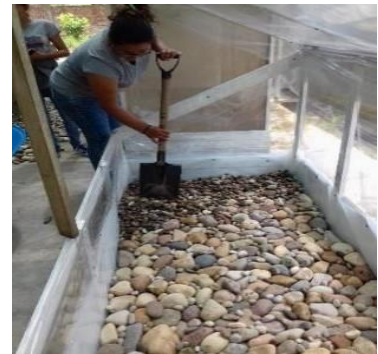
Construcción, forrado con plástico y colocación de piedras grandes, medianas y pequeñas, para sistema de difusión de agua en cámara de sub - irrigación.
